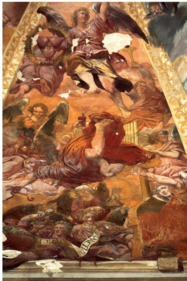
Obr 3. Chlumec, kaple Nejsvětější Trojice, klenební malby, detail severovýchodního pole. Foto: Vít Honys 2024
